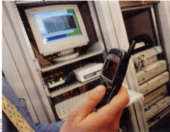
En attendant la refonte des applications, il existe plusieurs méthodes pour mettre en place un intranet mobile. L'une d'elles consiste à générer un code jumeau.
